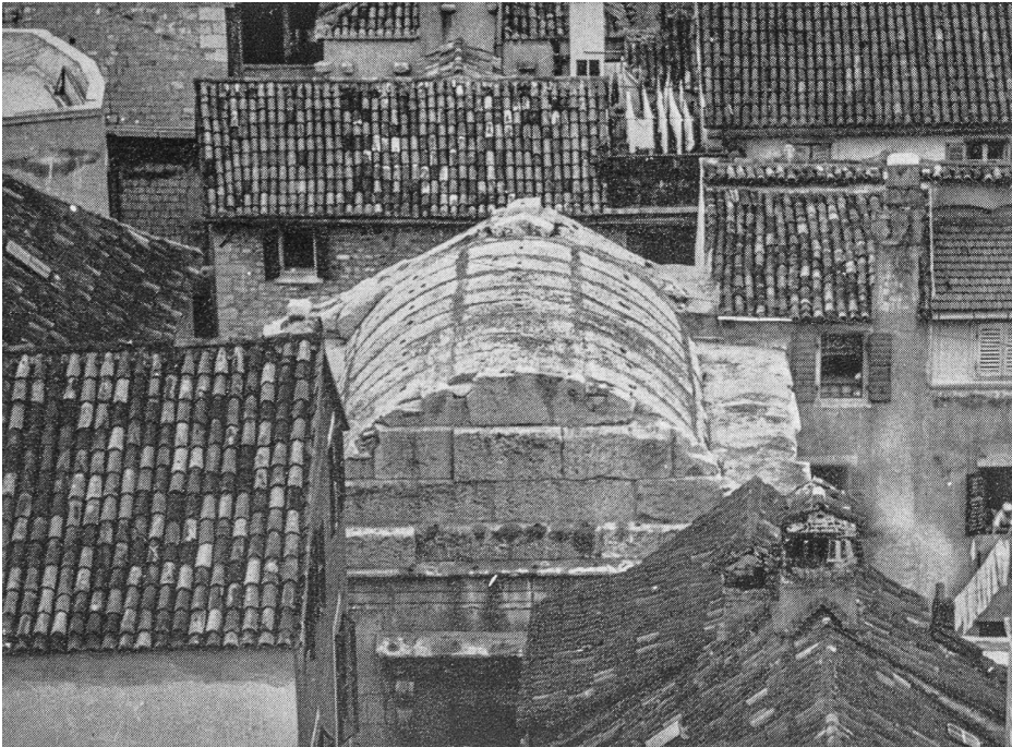
Abb. 58: Split, sog. Baptisterium, Tonnenwölbung.
